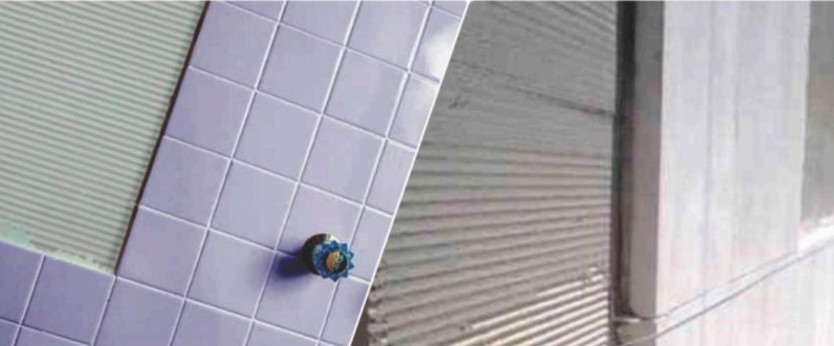
➤ Ejemplo de sistema de junta invisible.
