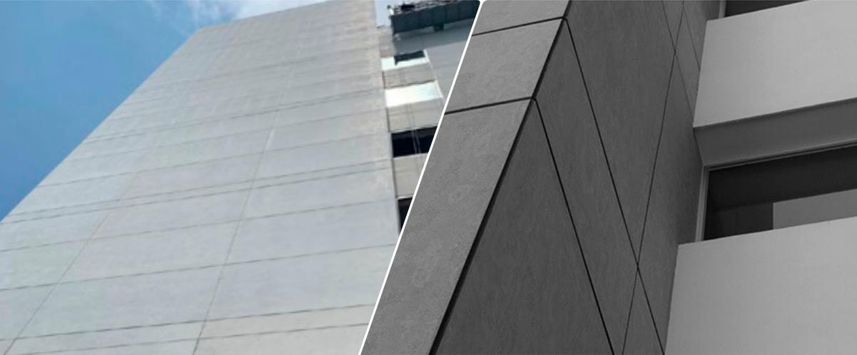
Ejemplo de sistema de junta flexible
